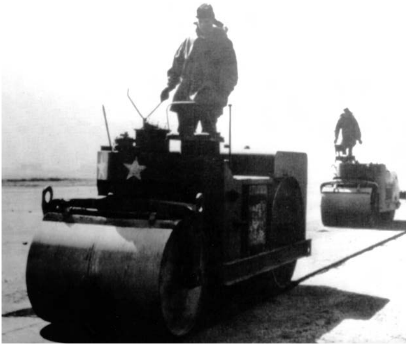
Rolling the asphalt.
